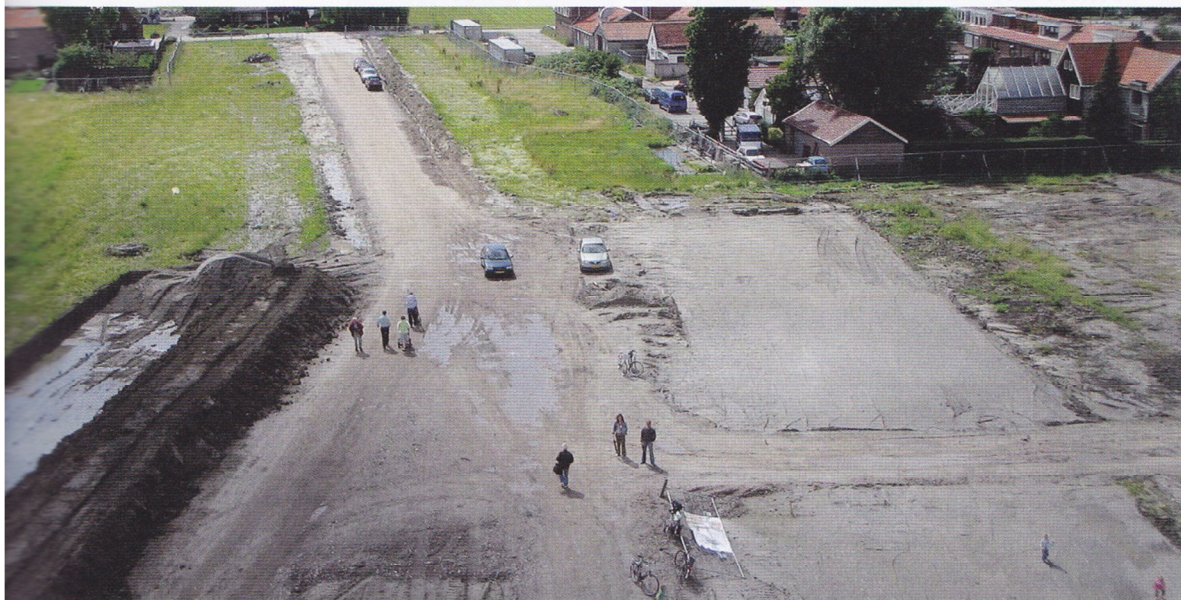
Bouwnijp maken van de wijk Nieuw-Rhijnegeest in Oegstgeest. FOTO'S: ROYAL HASKONING
